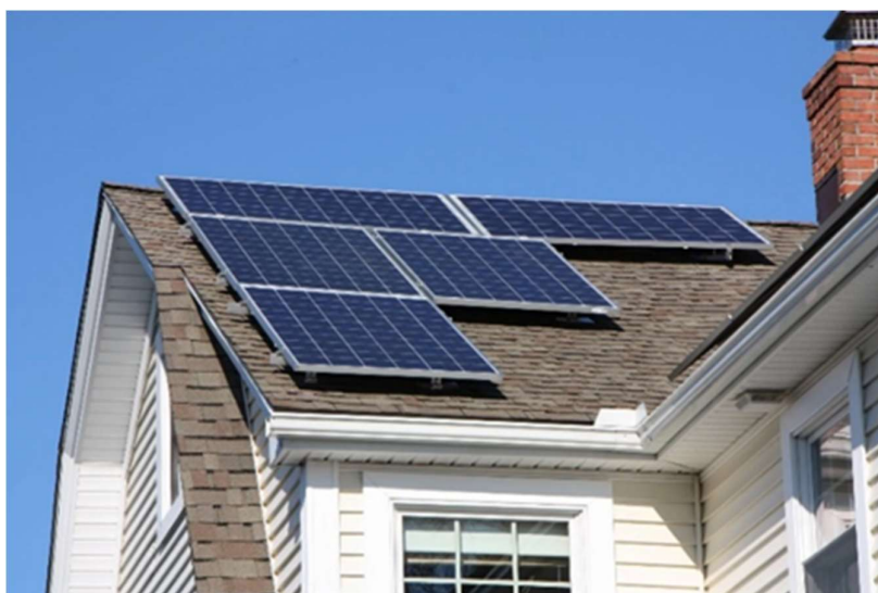
Obrázok 4: Strešná konštrukcia solárnych panelov
